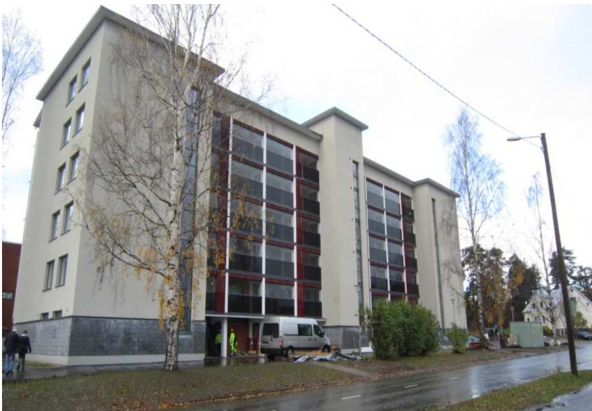
Kuva 5. Julkisivu jälkeen (Sormunen & Timonen Oy)
