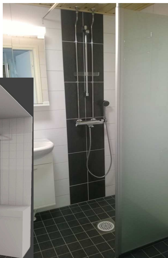
Kuva 3. Kylpyhuone jälkeen (Sormunen & Timonen Oy)
