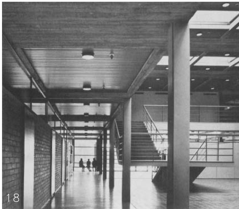
Puotilan ruotsinkielinen yhteiskoulu, Helsinki 1967, on Mies van der Rohelta vaikutteita saaneen koulukunnan manifestaatio. Rakenteellinen selväpiirteisyys kuvastuu mittajärjestelmässä, jossa samat mitat ja niiden kerrannaiset toistuvat niin vaaka- kuin pystysuunnassa. Erik Kråkström, Kirmo Mikkola ja Juhani Pallasmaa
