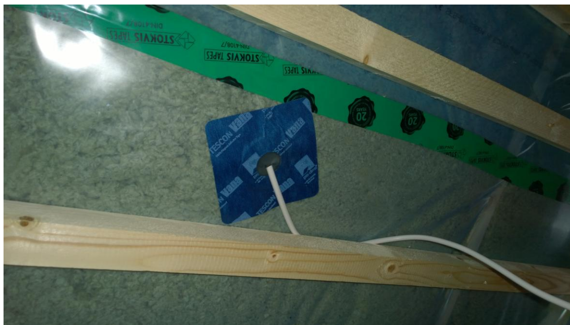
Kuva 14. Yläpohjan johdotus, jossa läpivientitarra
