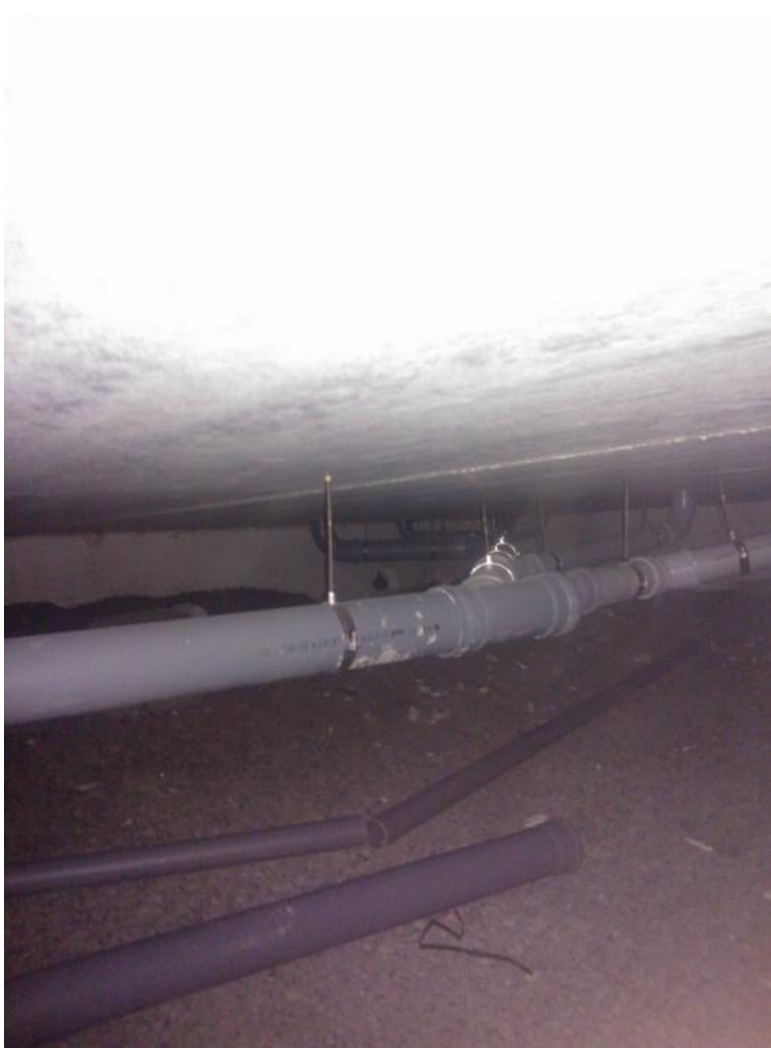
Kuva 8. Pohjaviemäreiden asennus alapohjassa
