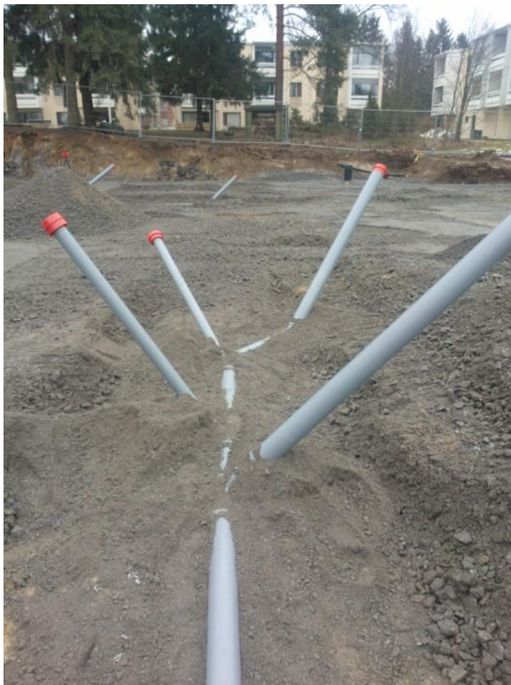
Kuva 6. Pohjaviemärien runko asennettuna ennen täyttöä (pohjaratkaisuna maanvarainen laatta).
