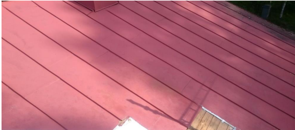
Kuva 6. Yksinkertainen hakasauma. (Kuva: Juho Rönkkö)
