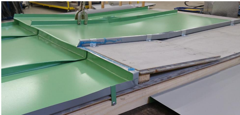
Kuva 11. Yksinkertainen hakasauma ja tiivistys. (Kuva: Juho Rönkkö)
