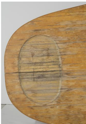
Kuva 6. Kosteusvaihteluista aiheutuneita rakoja
