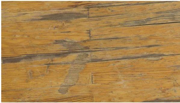
Kuva 7. Harmaantunut puu
