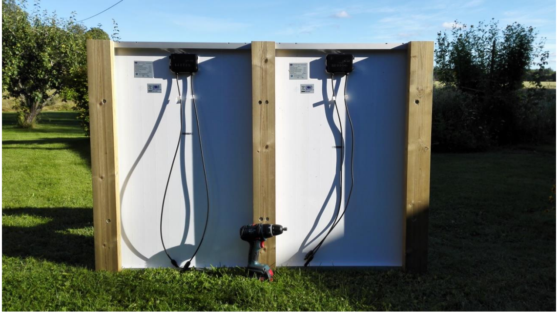
Kuva 6.2. Aurinkopaneelien teline.
