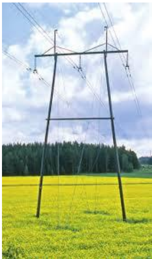
KUVA 1. Suurjännitelinjaa (Tiedä ennen kuin toimit)
