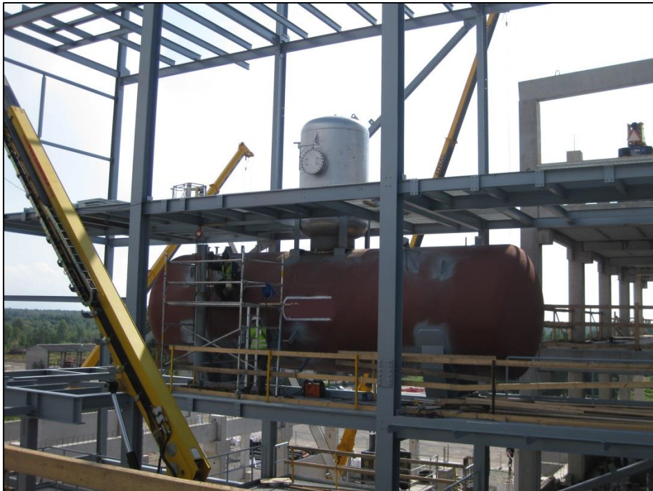
Kuvio 6. Syöttövesisäiliön ja kaasunpoistimen asennus (Anttila 2016)
