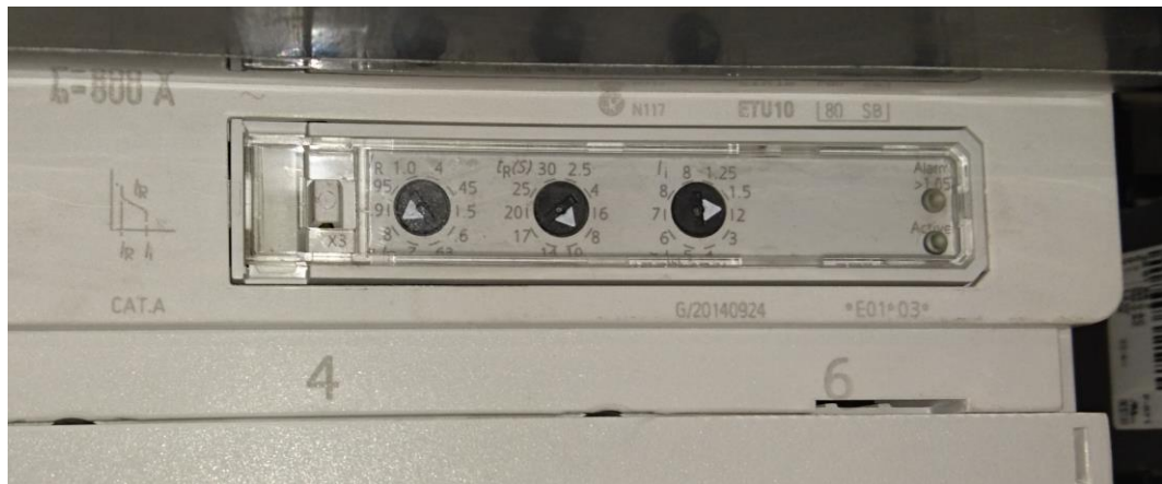
KUVA 13. Kompaktikatkaisijan säätöarvot, ensimmäinen säätö on kerroin kytkimen kokonaisvirrasta (800A*0,8), toinen säätö on laukaisuaika (8s) ja kolmas oikosulkuvirran kerroin(12*800A).
