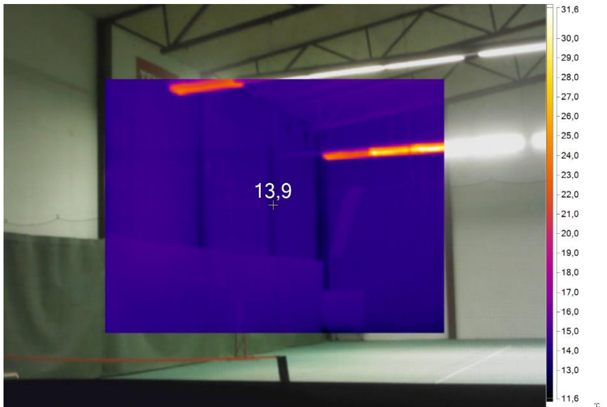
Kiinteärakenteisen hallin lounaisseinä, lämpökamerakuva
