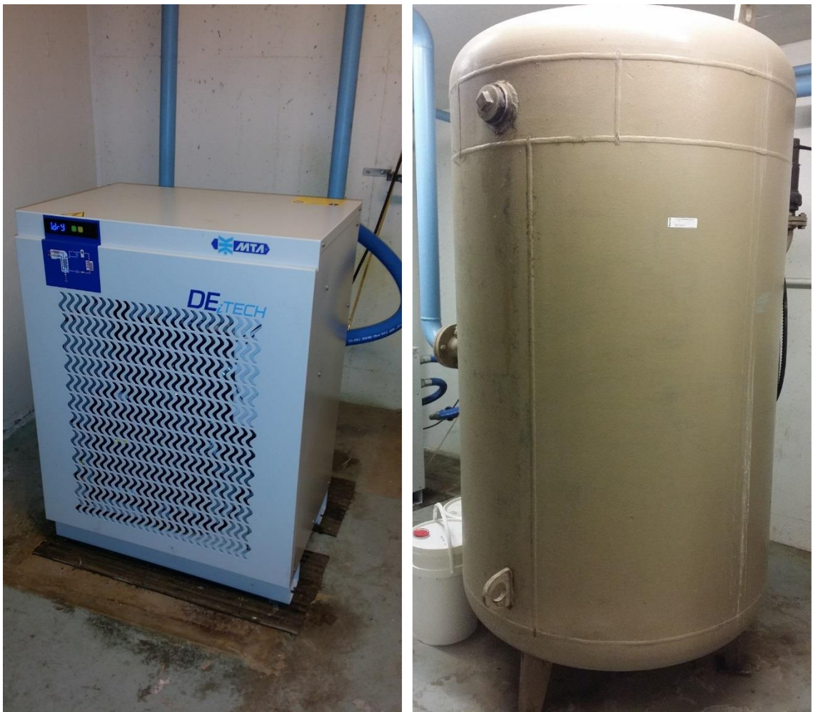
KUVA 8. Vasemmalla jäähdytinkuivain DEiT080, oikealla paineilmasäiliö
