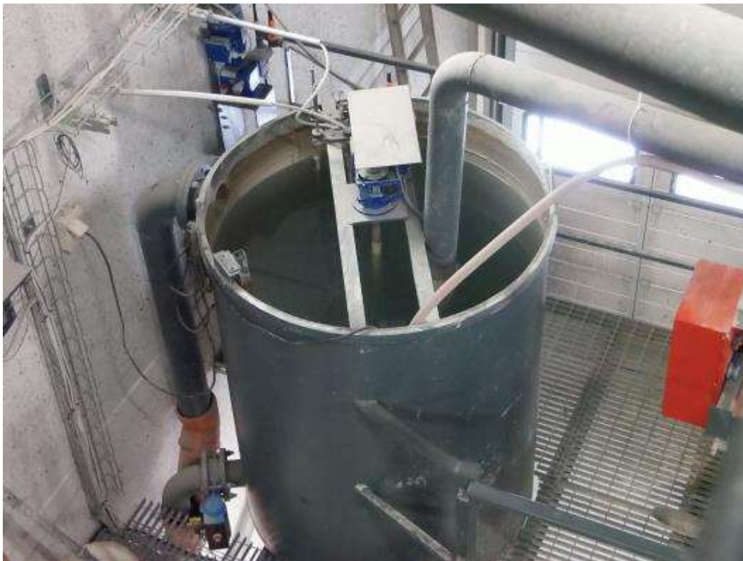
Kuva 10. Prosessiveden neutralointisäiliö.
