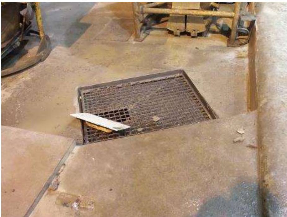
Kuva 3. Jätebetonin syöttökohta lattiassa.
