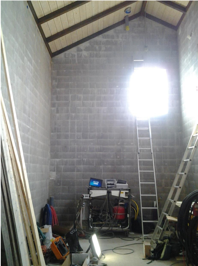
KUVA 5. Kuivain asennettuna työmaalle
