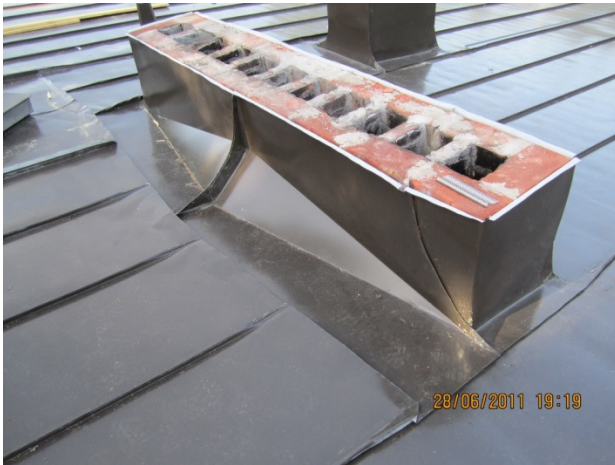
Kuva 5. Peltisepän työn jälkeä, piipun taustakaato. (17.)
