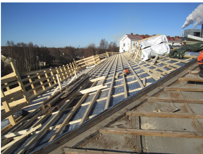
Kuva 20. Neljäkymmentä vuotta vanhan katon kermikerroksen paksuus on n. 50mm. (17.)
