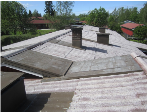
Kuva 23. Varttikatossa on kaksi asbestitonta levyä. (17.)
