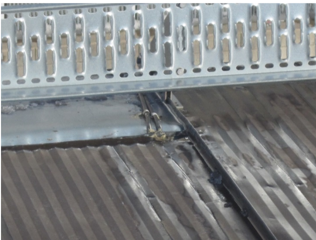
Kuva 15. Vanha pinnoitettu konesaumakatto, keskustassa lumiesteet tulee olla normaalia vankemmat. (17.)
