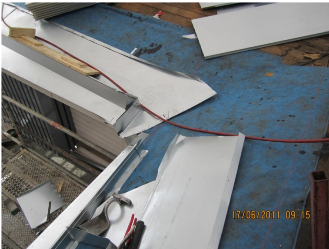
Kuva 5. Peltisepän työn jälkeä, piipun taustakaato. (17.)
