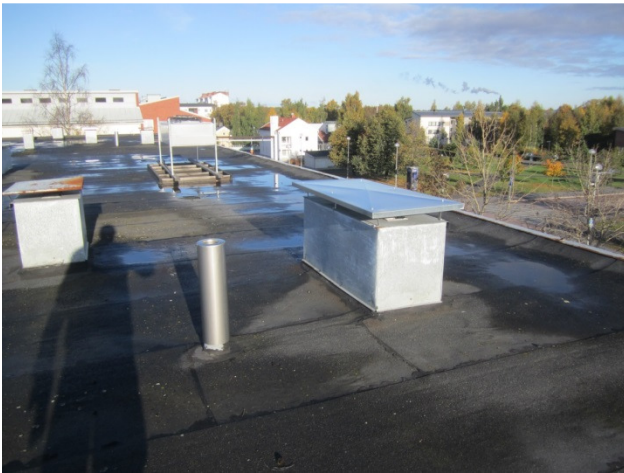
Kuva 17. Poimuja ja höyrypusseja kermikatossa. (17.)
