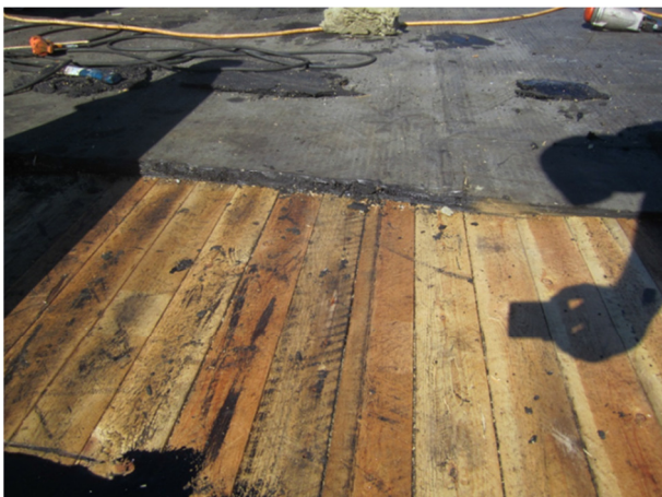
Kuva 20. Neljäkymmentä vuotta vanhan katon kermikerroksen paksuus on n. 50mm. (17.)
