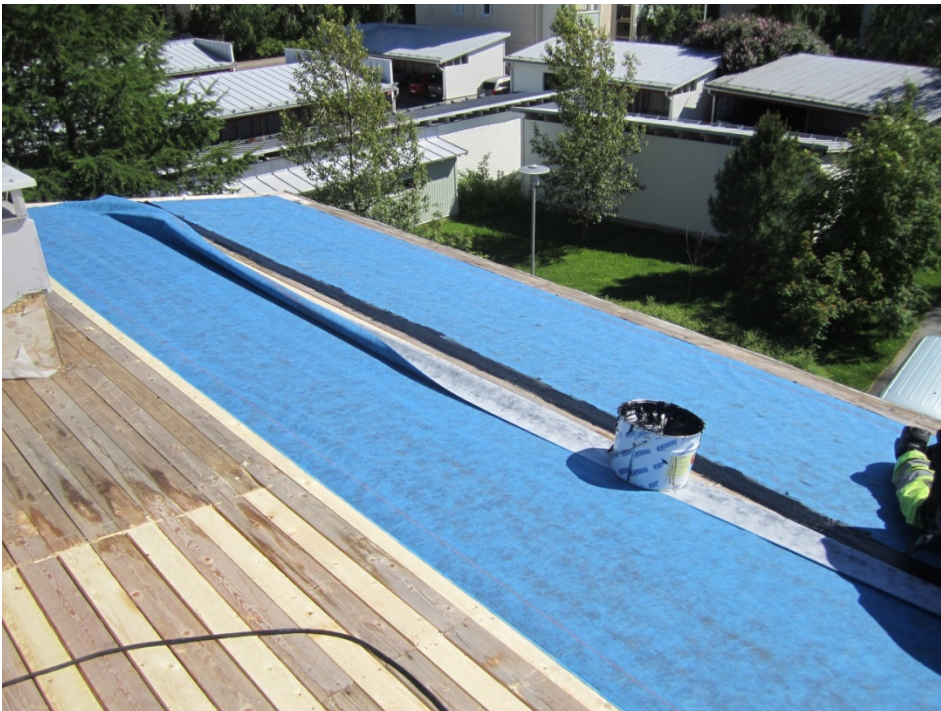
Kuva 7. Konesaumakaton uusiminen hupun alla, alusrakenteena levy ja aluskatteena liimattava bitumikermi. (17.)
