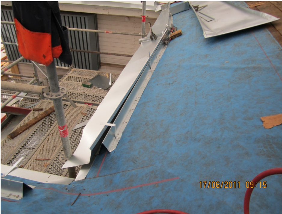
Kuva 12. Konesaumakatolla piipuissa ei ole taustakaatoja. (17.)
