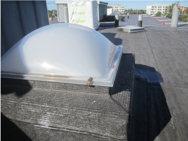
Kuva 26. Rikkinäiset ja uv-säteilyn haalistamat kattokuvut tulee uusia. (17.)
