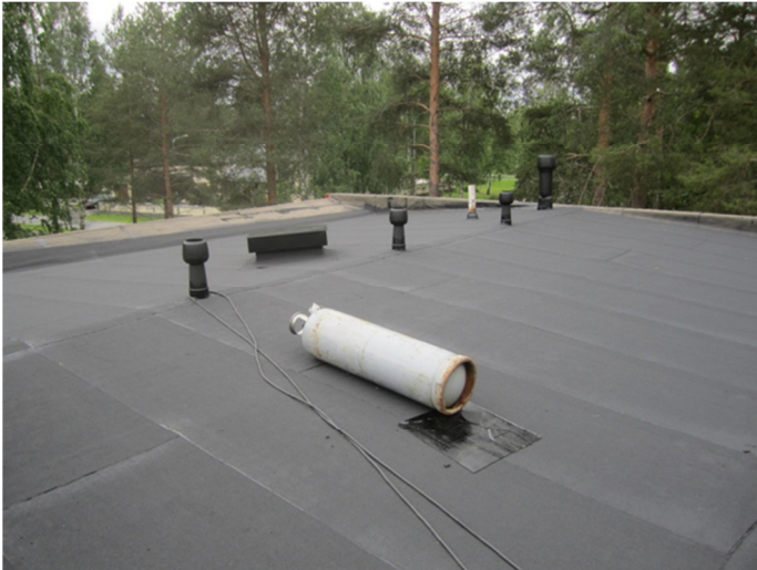
Kuva 29. Rivitalon katon alipainetuuletin. (17.)
