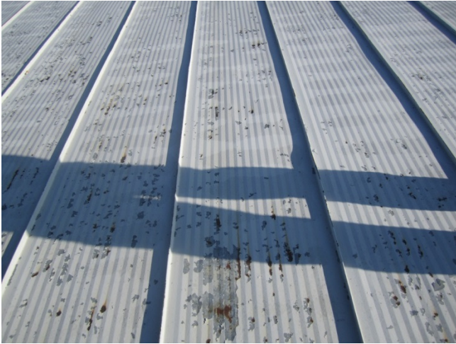
Kuva 2. Vanhan konesaumakaton pinnoite on irtoamassa. (17.)
