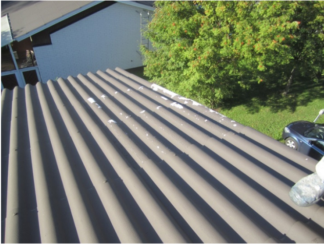
Kuva 23. Varttikatossa on kaksi asbestitonta levyä. (17.)
