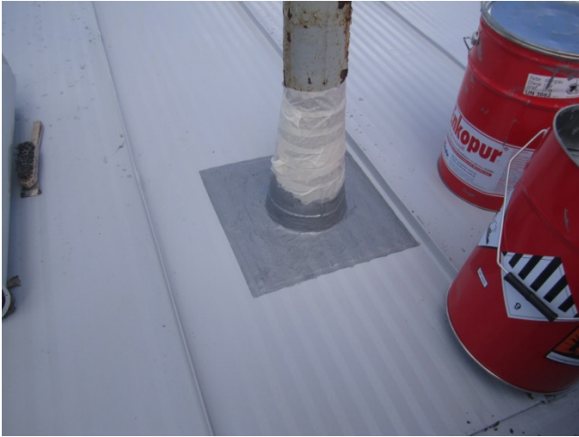
Kuva 14. Eräs massakorjausmenetelmä. (17.)
