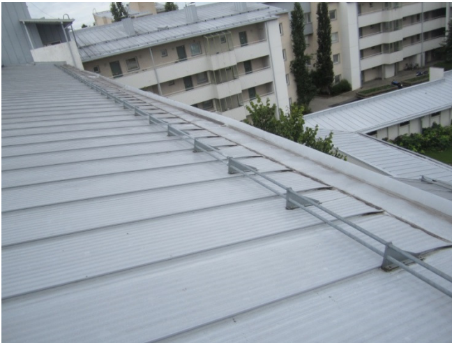
Kuva 9. Konesaumakatoilla tiivistysaineena yleisesti käytetty valssiöljy. (17.)
