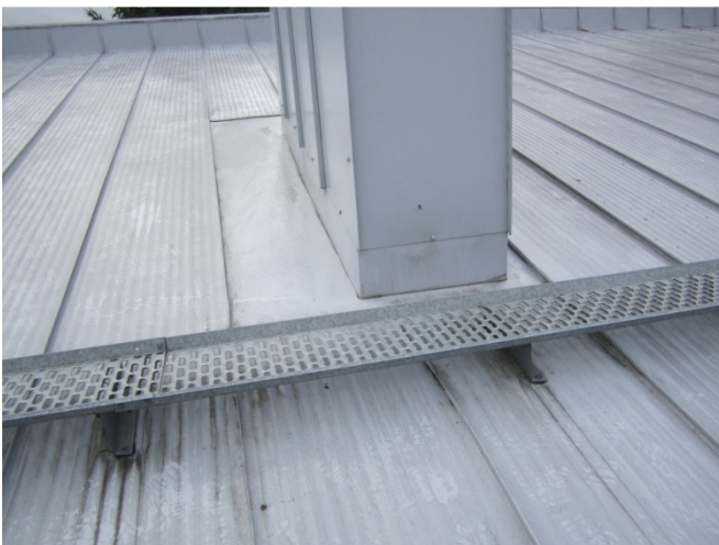
Kuva 11. Konesaumakatolla huoltosilta on pultattu katteen läpi. (17.)
