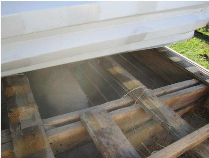
Kuva 29. Rivitalon katon alipainetuuletin. (17.)
