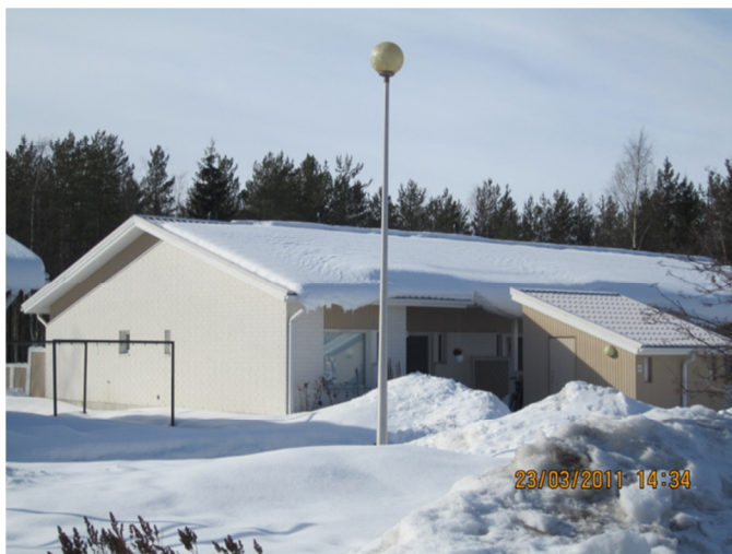
Kuva 1. Lyhyt lumieste profiilipeltikaton sisäänkäynnin kohdalla pitää koko katon lumia paikoillaan. (17.)
