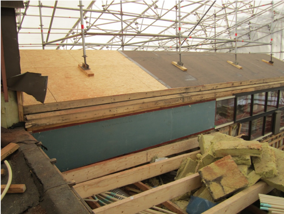
Kuva 7. Konesaumakaton uusiminen hupun alla, alusrakenteena levy ja aluskatteena liimattava bitumikermi. (17.)
