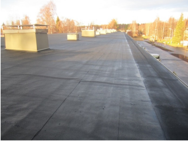
Kuva 17. Poimuja ja höyrypusseja kermikatossa. (17.)
