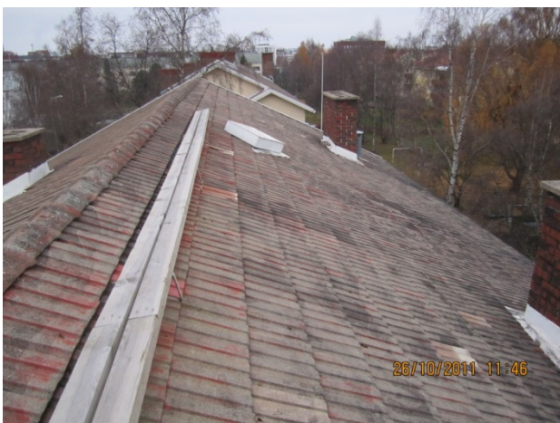
Kuva 21. Vanha tiilikate uusitaan tiilikatteeksi. (17.)
