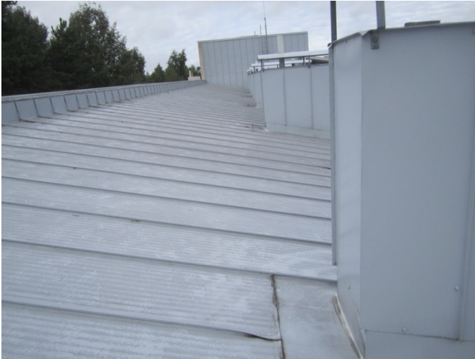
Kuva 12. Konesaumakatolla piipuissa ei ole taustakaatoja. (17.)
