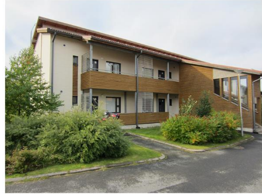
KUVIO 5. Talvikankaantie 11 rakennuksen A etupiha
