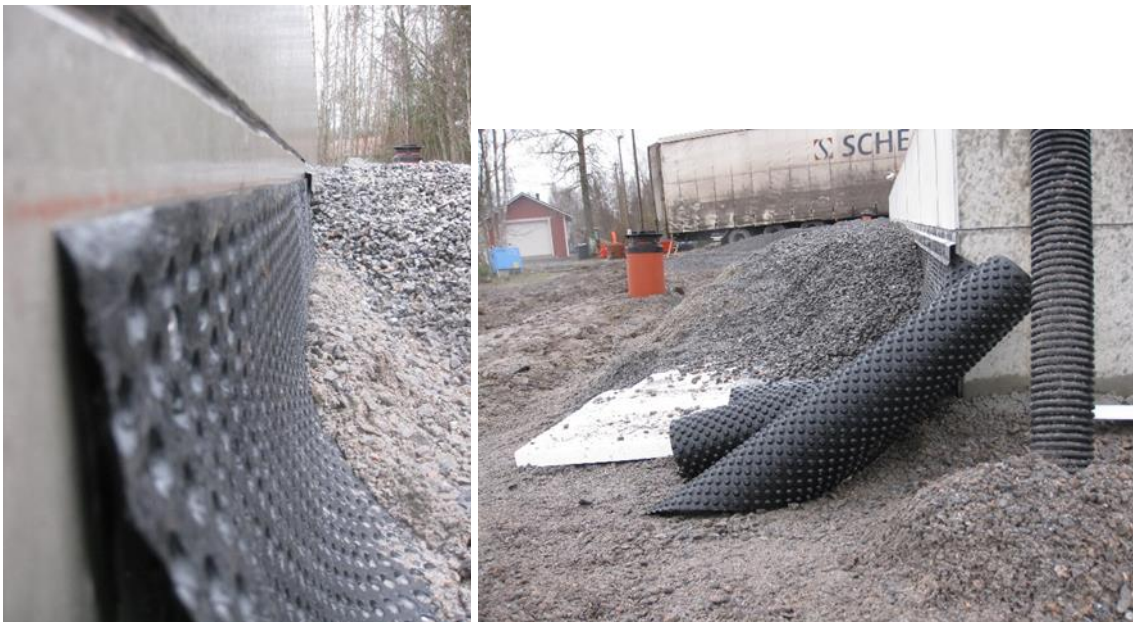
Figur 56. Då alla ojämnheter på sockeln var åtgärdade, installerades sockelskivan.
