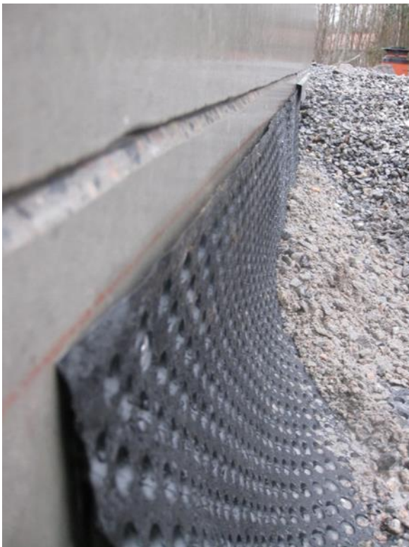
Figur 60. Hack för listens övre kant skärt i sockeln.
