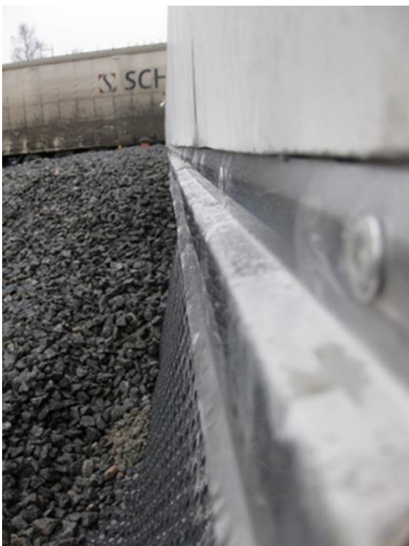
Figur 61. Kantlisten fastsatt mekaniskt i sockeln.
