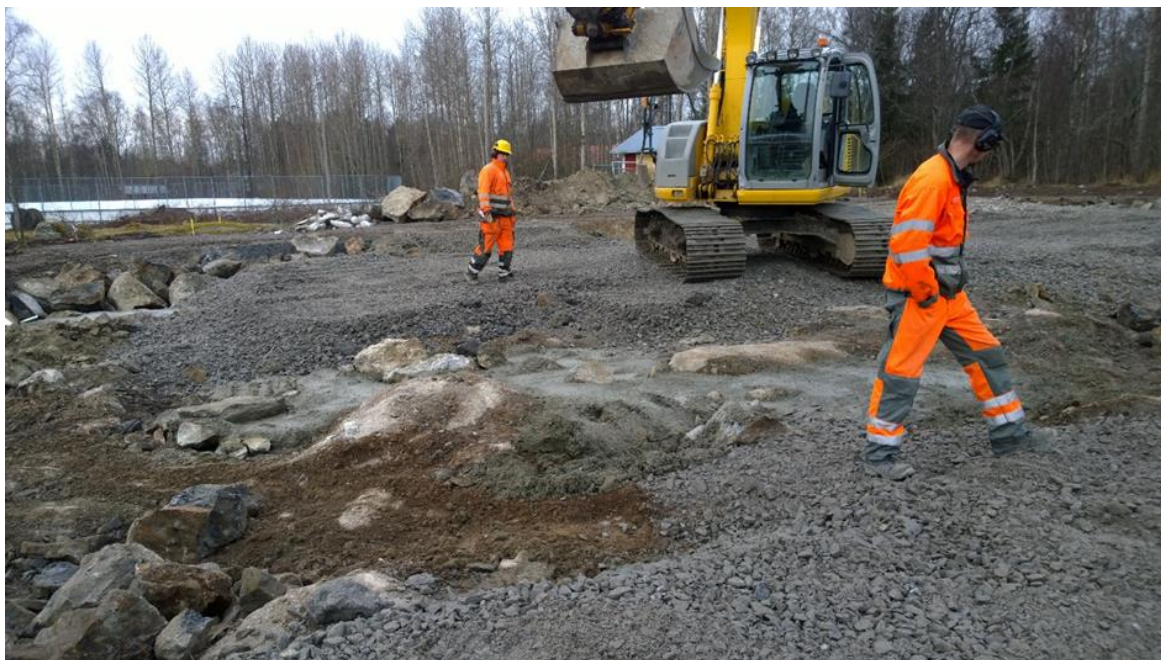
Figur 28. Fickorna igen gjutna och bergstopparna bortsprängda. Krossgrus #0-32 & #0-65 förs ovanpå.
