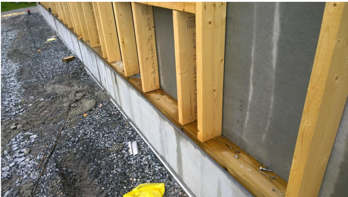
Figur 79. Syllen var utsatt för nederbörd och innehöll rikligt med vatten. Uttorkningen påskyndades med hjälp av klimatskydd och värmeförsel.
