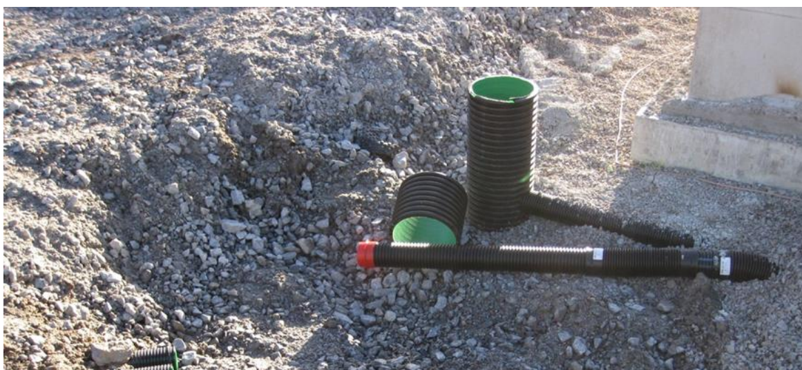
Figur 45. Dräneringsrör samt granskningsbrunn installerat (skilt rör för dagvatten). Dräneringsrören placerades i markskiktet då byggnadens grundsula och sockel var byggd.
