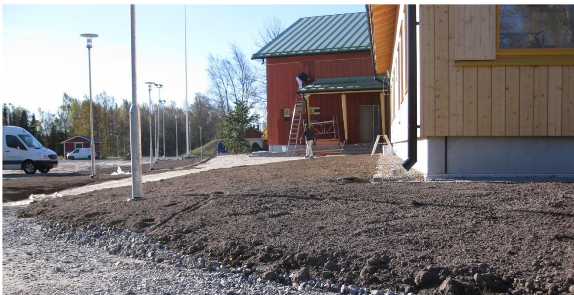
Figur 40. Markytan runt byggnaden sluttar från sockeln.
