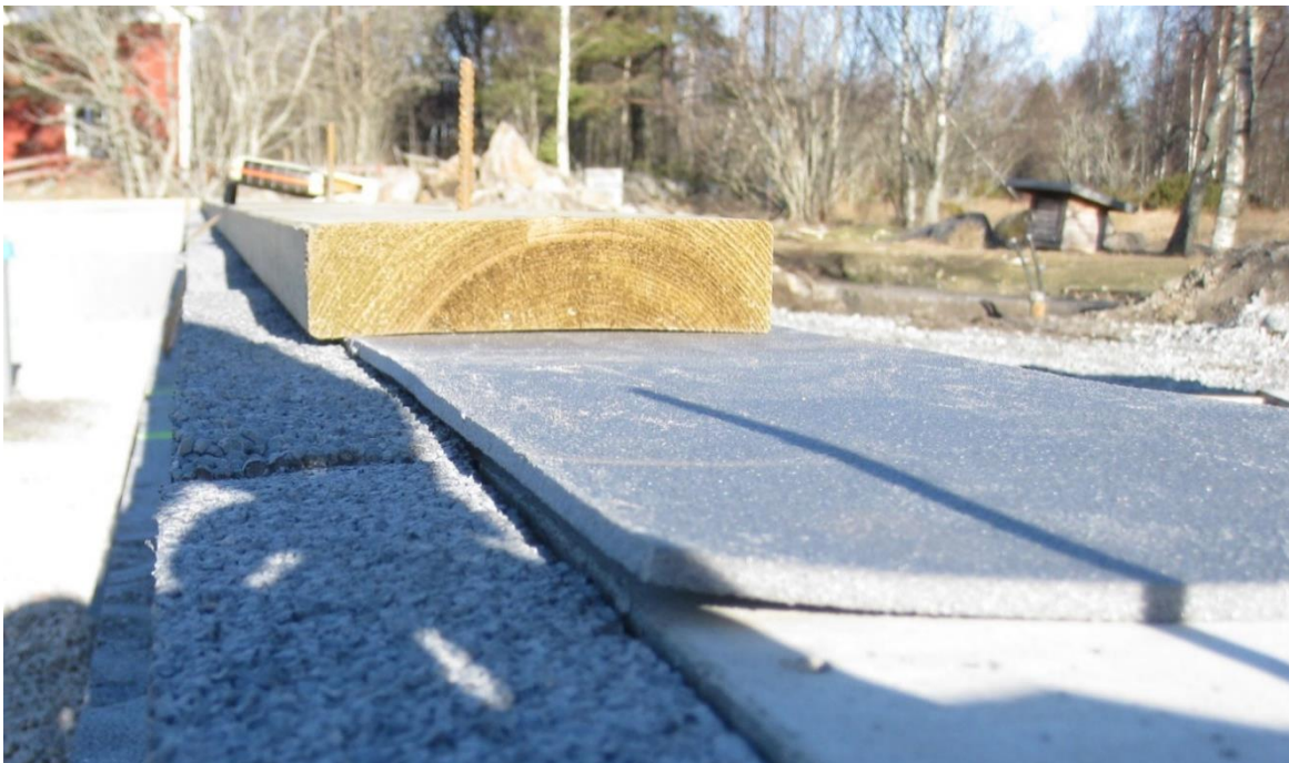
Figur 77. Sillisolering byggdes in mellan syllen och sockeln.
