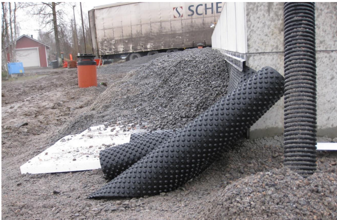
Figur 50. Tjälisoleringen har en lutning från byggnaden. Plastfilmen kan inte ses i bilden eftersom den är genomskinlig.
