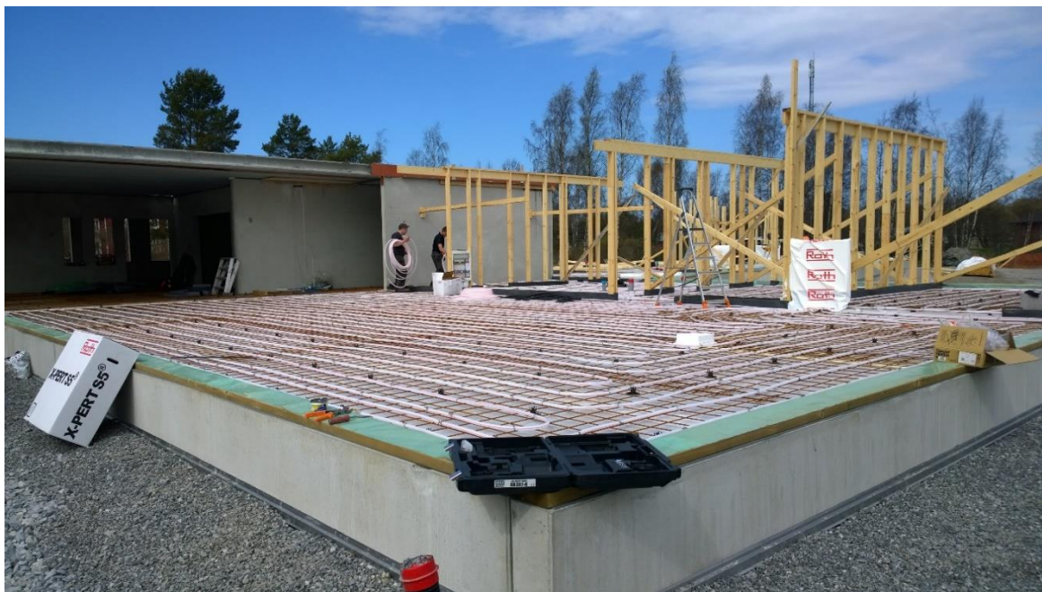
Figur 69. Kapillärbrytande skiktet, värmeisoleringen, fiberduken, armeringen för betongplattan och stor del av golvvärmslingorna byggda. Plastfilm fört in under värmeisoleringen.
