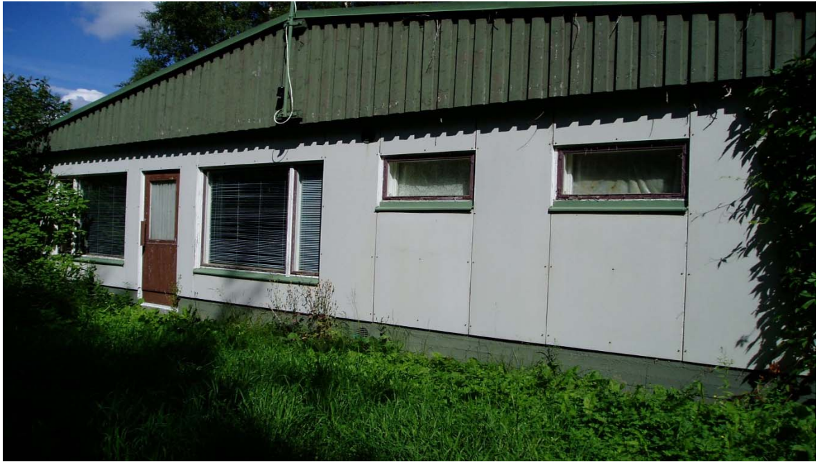
Kuva 3. Länteen oleva julkisivu ennen korjausta.
