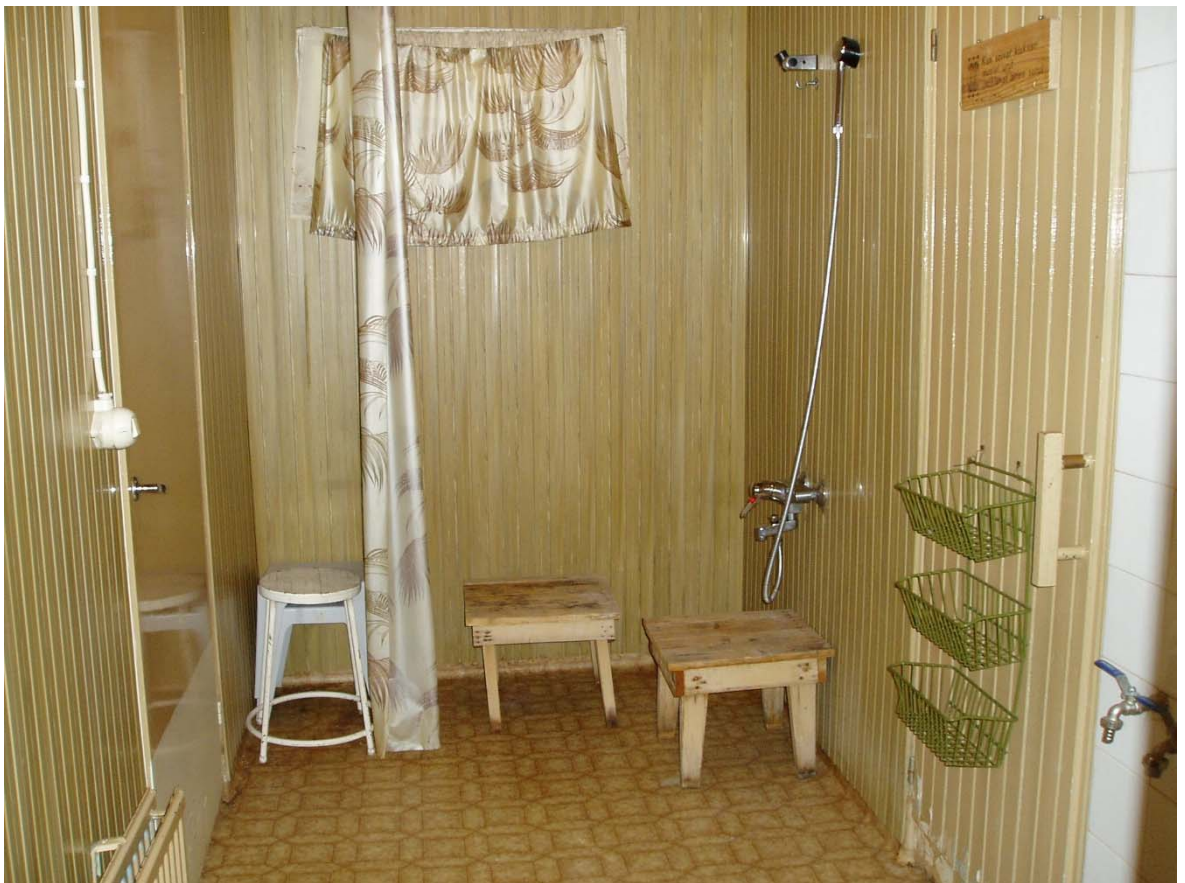
Kuva 1. Pesuhuoneesta kuva ennen remonttia.
