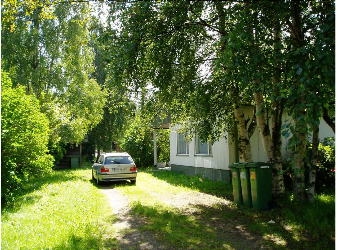
Kuva 2. Sisäänkäynnin julkisivu ennen korjausta.
