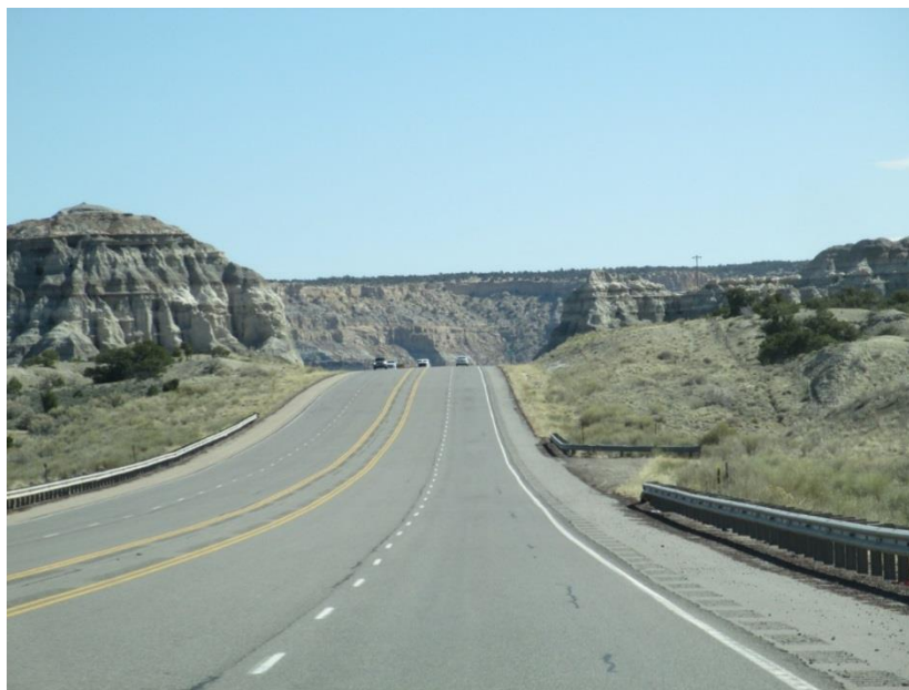
Kuva 2 Highway 550 Amerikan Yhdysvalloissa, jossa leveän keskimerkinnän kokeilu toteutettiin 2008
