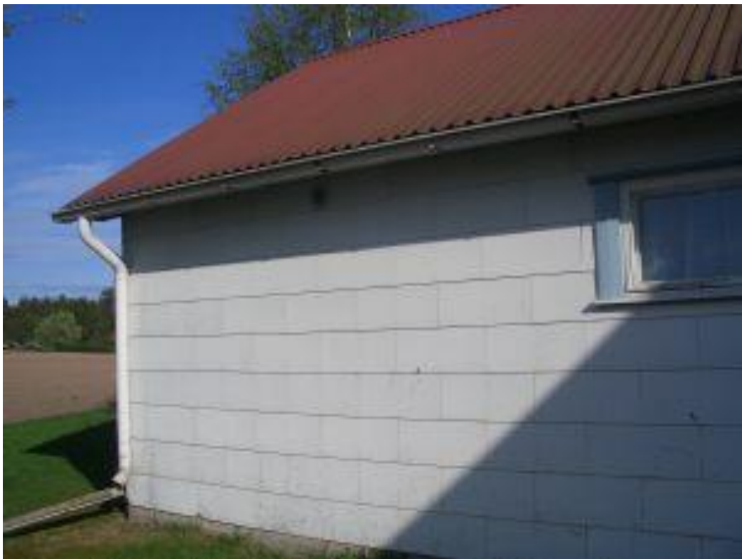
Kuva 7. Mineriitti julkisivu. (Rakennusperintö 2016)
