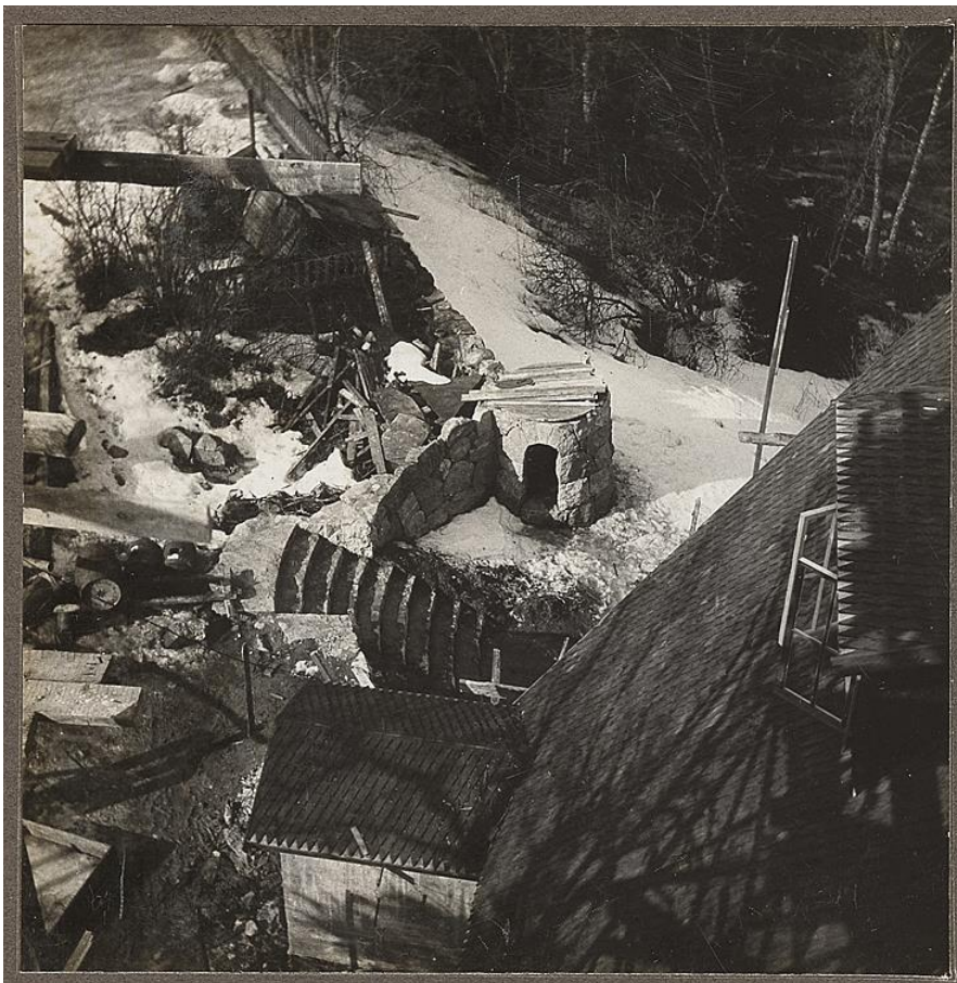
Kuva 8 Muurien ja portaiden rakentamista Tarvaspäässä, 1912 (Valokuva Tarvaspää, 1912)
