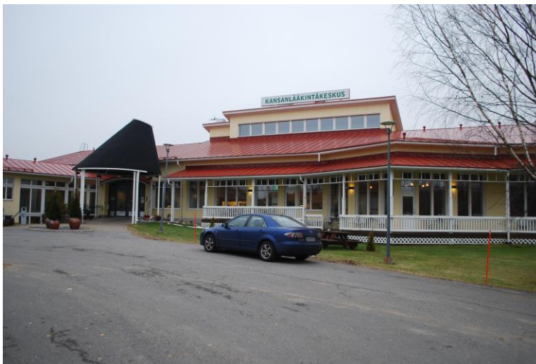
KUVA 1. Kansanlääkintäkeskuksen julkisivu ja sisäänkäynti (Kuva Outi Siekkinen)
