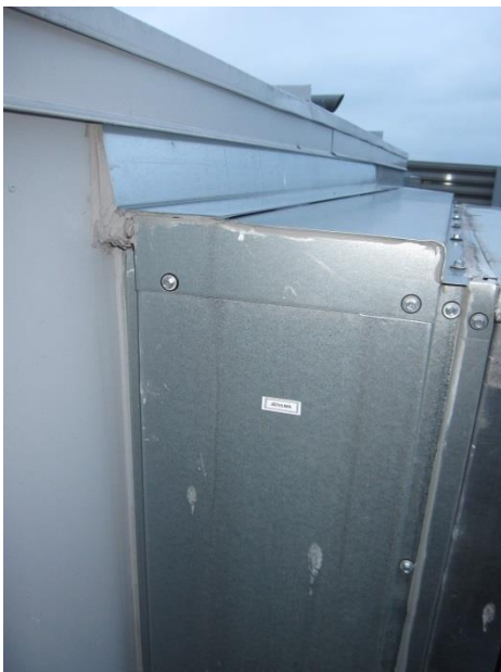
Kuva 48. Esimerkki poistoilmalämpöpumpun ja kokoojakammion välisen joustavan kanavaliitoksen sadesuojuksesta.
