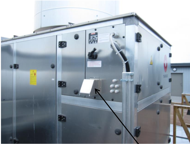
Kuva 52. Ulkoilma-anturi suojakotelossa.
