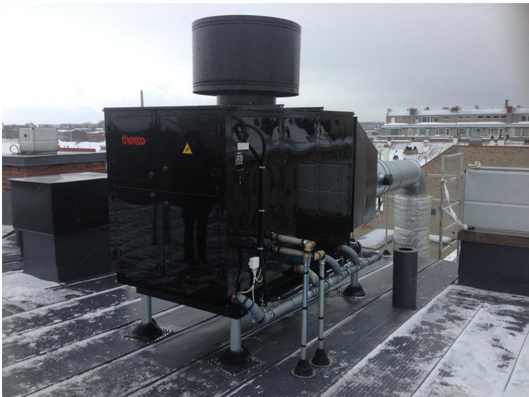
Kuva 63. Esimerkki asuinkerrostalon vesikatolta Keski-Euroopassa. Asennustyöt vielä kesken.
