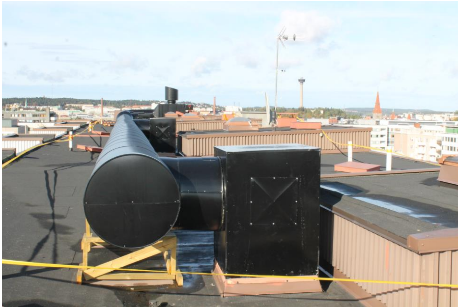
Kuva 62. Esimerkki asuinkerrostalon vesikatolta Tampereelta.
