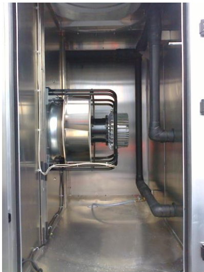
Kuva 44. Poistoilmalämpöpumpun poistopuhallinkammio
