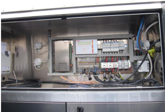
Kuva 46. Poistoilmalämpöpumpun ohjauspaneeli
