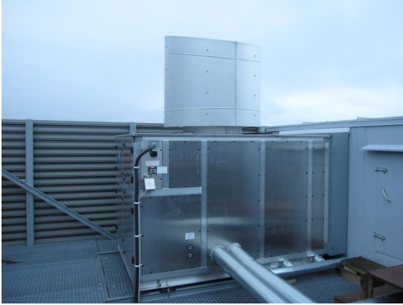
Kuva 60. Esimerkki 8-kerroksisen asuinkerrostalon vesikatolta.
