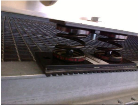
Kuva 47. Esimerkki tärinäneristimestä, joita asennetaan 4 – 6 kpl asennusjalustaa kohti.
