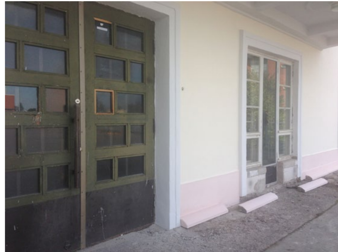
Kuva 35. Malmin aseman julkisivu korjauksen ja maalauksen jälkeen.
