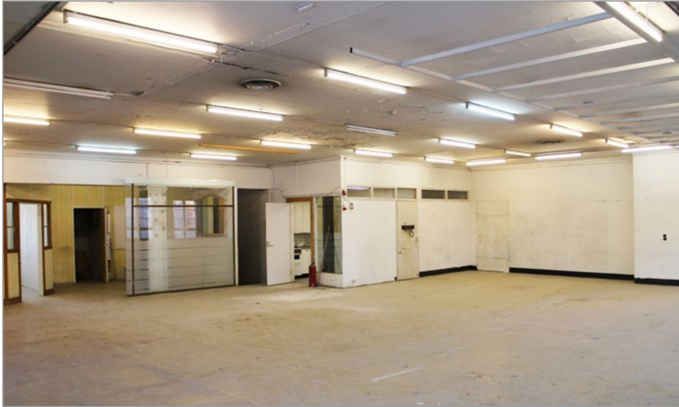
Kuva 32. Malmin aseman sisätilat 2014. Kuva Anne Riikonen
