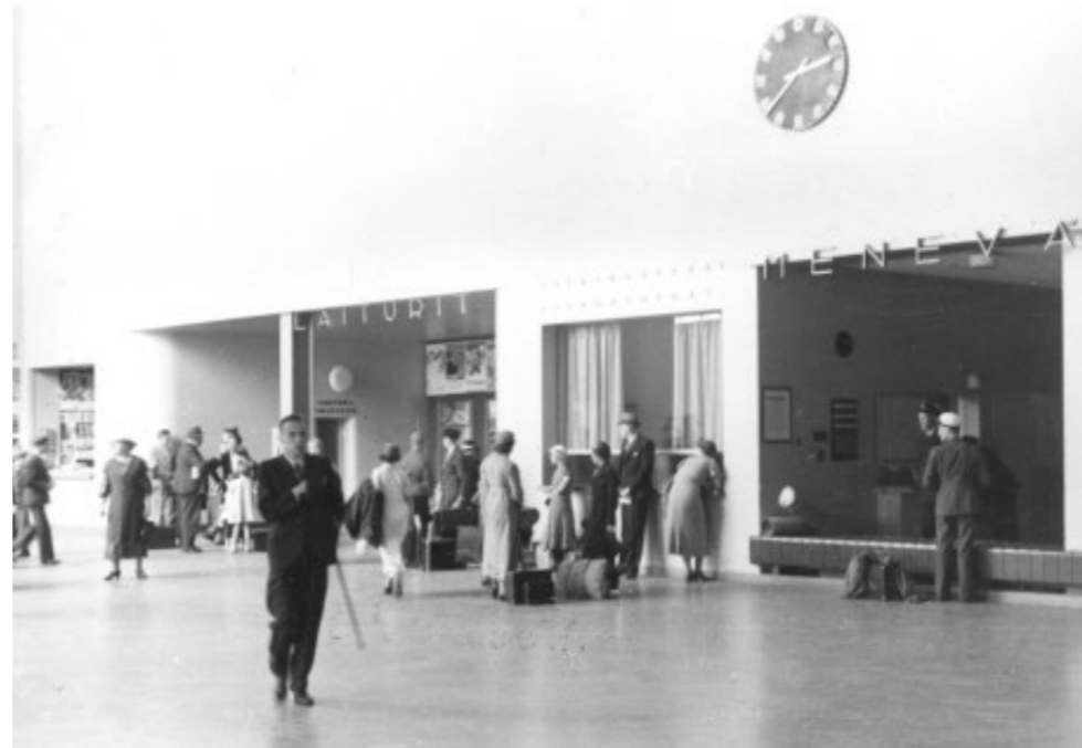
Kuva 50. Tampereen rautatieaseman odotushalli vuodelta 1936. Suunnittelijat Eero Seppälä ja Otto Flodin. Kuva Foto Roos.
