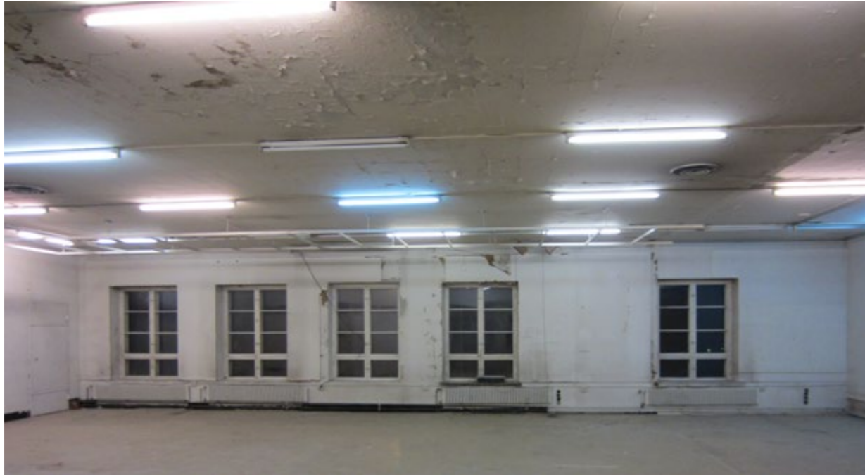
Kuva 93. Malmin vanha asema, patterit ikkunoiden alla.
