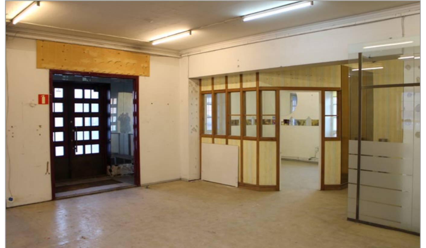
Kuva 33. Malmin aseman sisätilat 2014. Kuva Anne Riikonen
