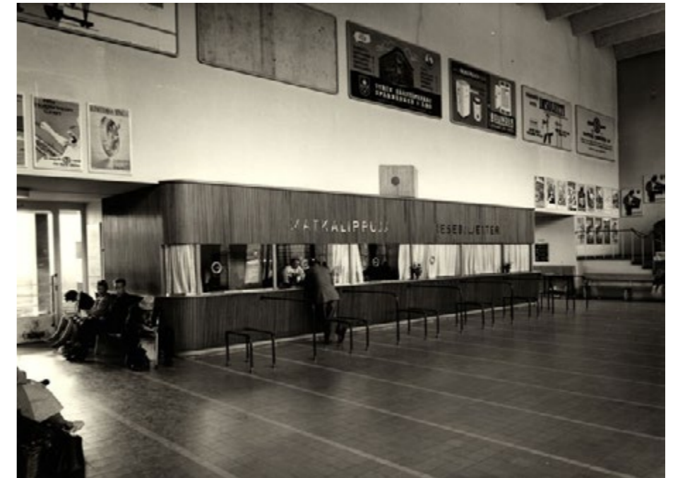
Kuva 51. Turun rautatieaseman lipunmyynti ja odotushalli. Rakennus valmistui vuonna 1940, suunnittelijoina Martti Välikangas ja Väinö Vähäkallio. Kuva Olavi Karasjoki.
