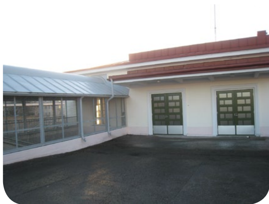
Kuva 38. Malmin aseman julkisivu 2015, ulko-oven korjauksen jälkeen.
