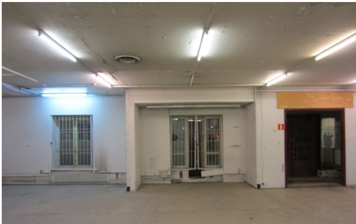
Kuva 94. Malmin vanha asema, patterit ikkunoiden alla.
