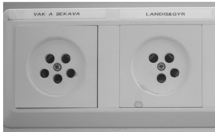
5 ja 4 napainen puhelinpistorasia
