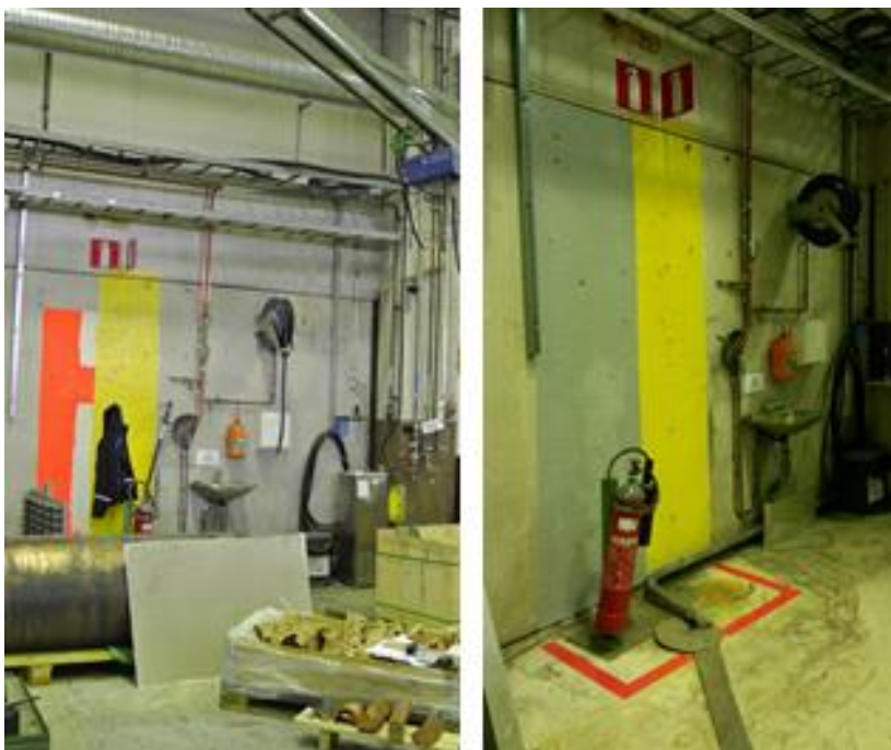
Kuva 4. Eräs palosammutin ennen ja jälkeen 5S:n.
