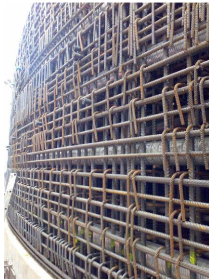
Kuva 2. Olkiluoto 3 primäärisuojarakennus raudoitusvaiheessa (Ydinvoimalaitoksen rakennesuunnittelu, 60).
