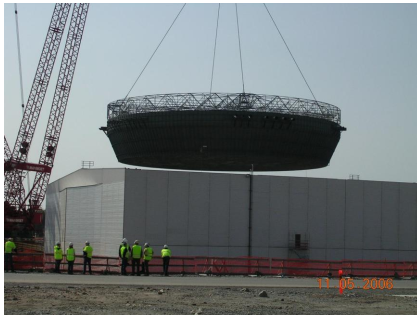
Kuva 10. OL3 Suojarakennuksen liner:n pohjalohkon nosto (Ydinvoimalaitoksen rakennesuunnittelu, 71).
