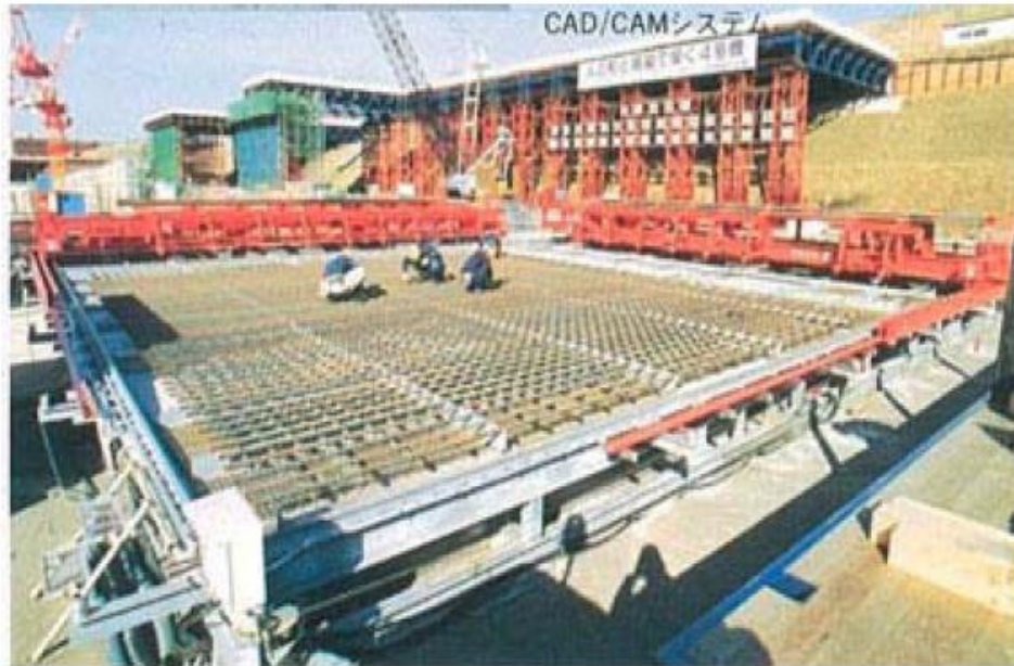
Kuva 29. SC-rakenteisen seinän esivalmistus ja kokoonpano (Advance., 10).
