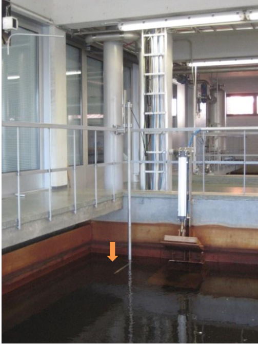
KUVA 4. Online UVAS -mittari hiekkasuodattimella 1, mittausanturi on 4–5 cm pinnan alapuolella (merkitty nuolella)
