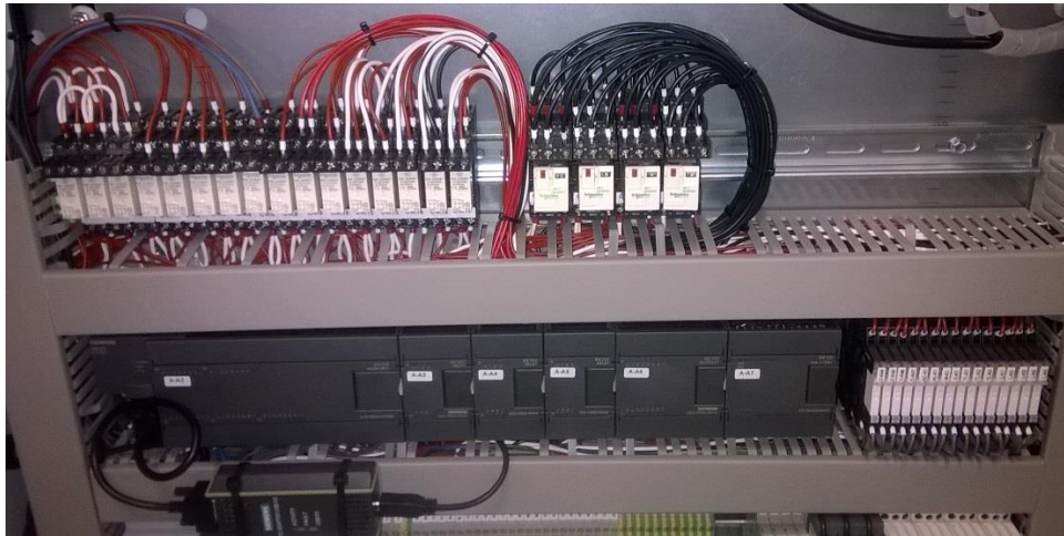
Kuva 13. S7-200 logiikka testilaitteella
