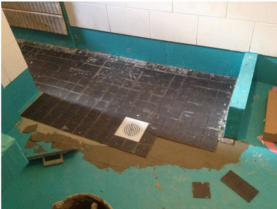
Kuva 30. Lattian laatoitus.
