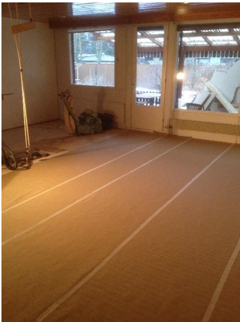
Kuva 5. Lattian suojaus.
