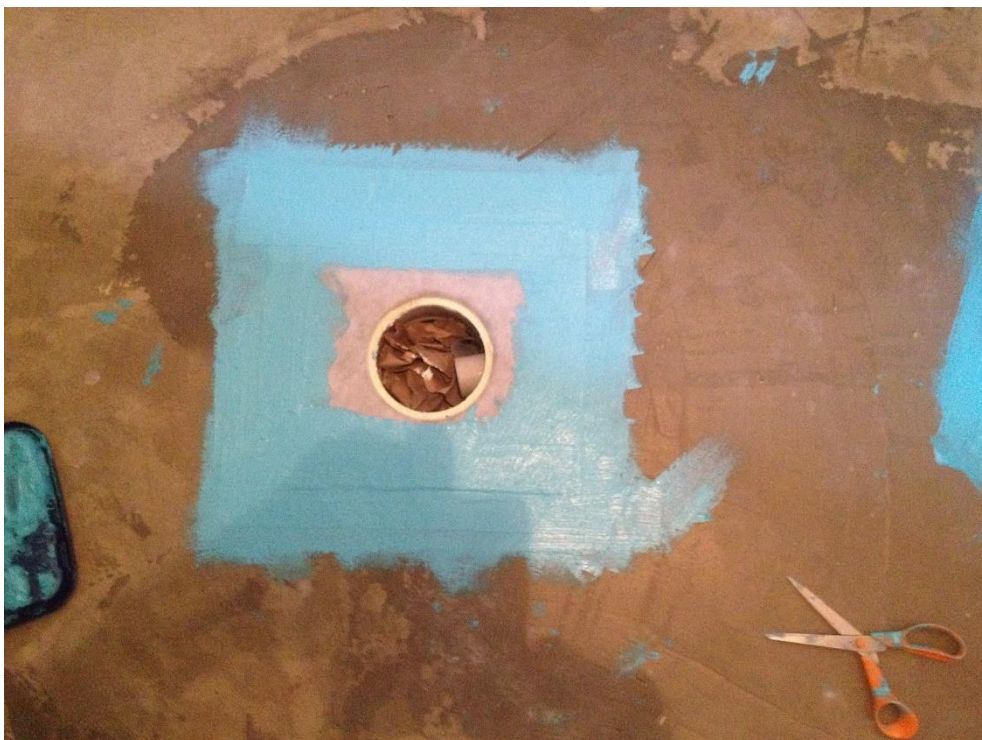
Kuva 24. Kaivon butyylilaippa laminoituna vesieristeeseen.
