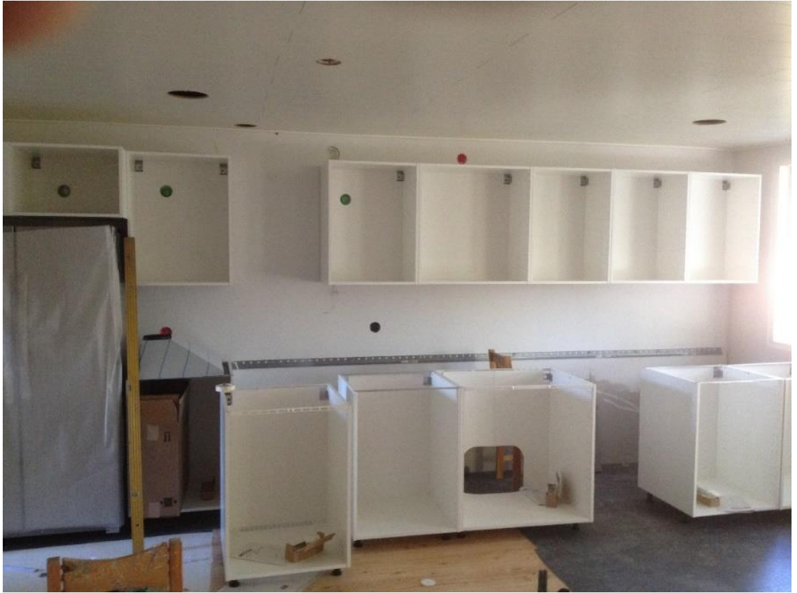
Kuva 12. Keittiökaapistojen asennus.
