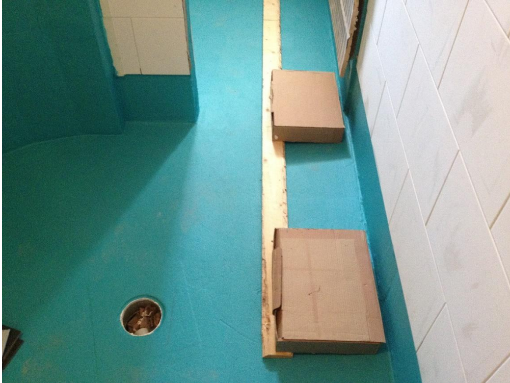
Kuva 26. Vesieristetty lattia, laatoituksen linjalauta.
