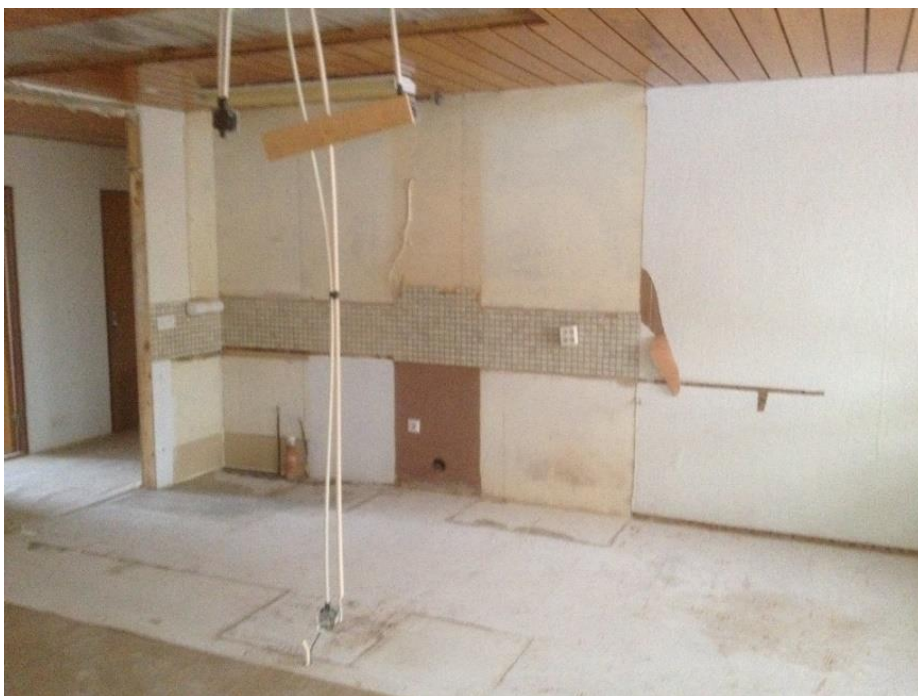
Kuva 3. Keittiö väliseinän purkamisen jälkeen.
