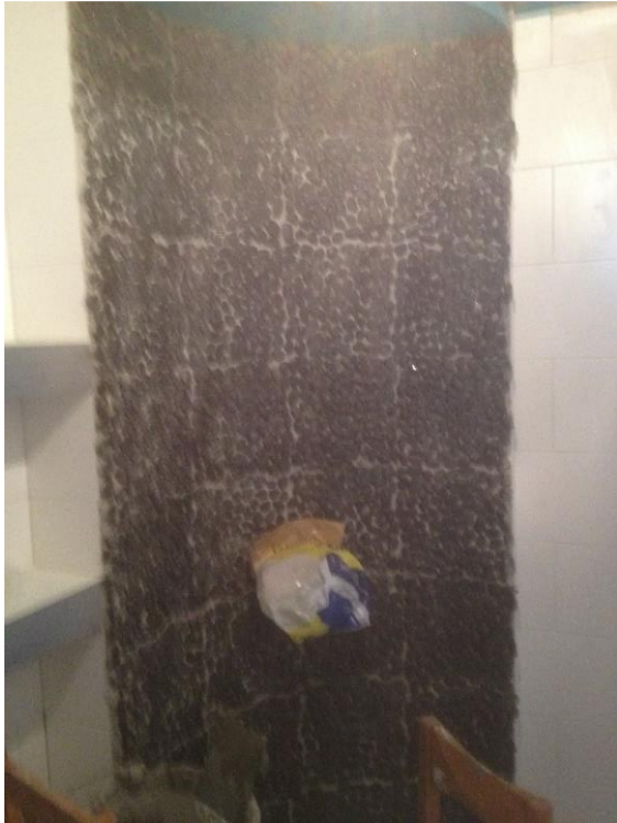
Kuva 28. Uuden suihkunurkkauksen saumaus.
