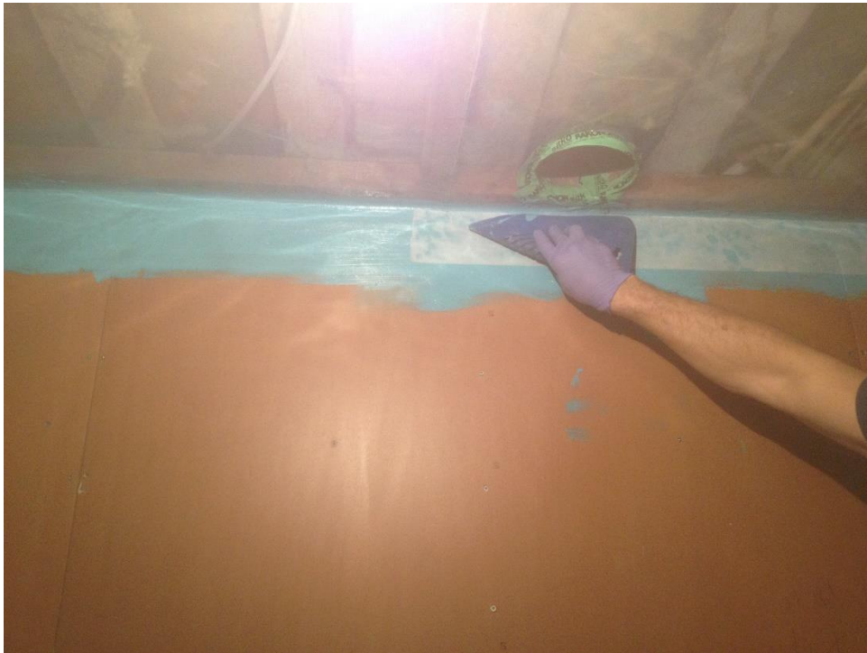
Kuva 22. Katon höyrynsulkumuovin laminointi vesieristeeseen.
