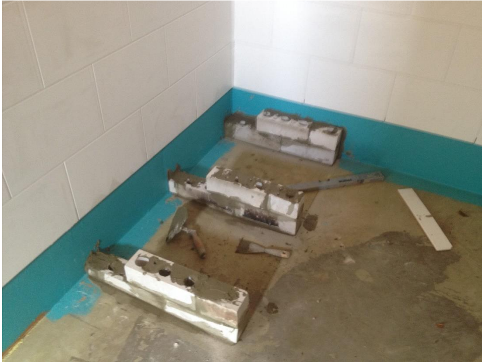
Kuva 31. Pesukoneen ja kuivausrummun korokkeen muuraus.
