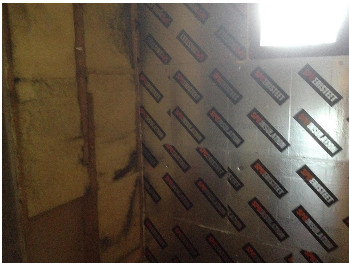
Kuva 32. Polyureetanilevyn asennus.
