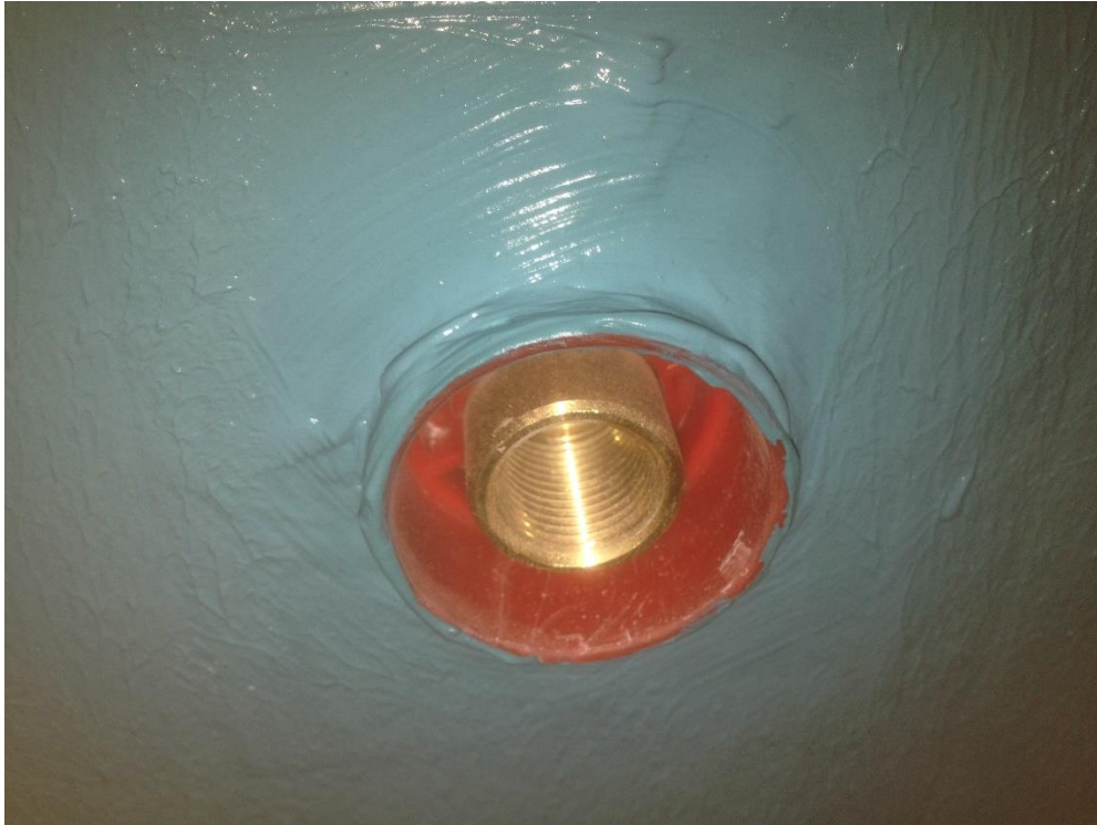
Kuva 25. Vesieristetty hanakulmarasia.
