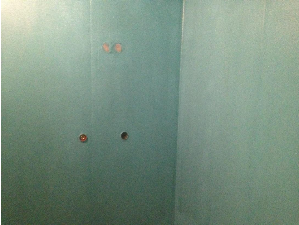
Kuva 23. Ensimmäinen vesieristekerros levitetty.
