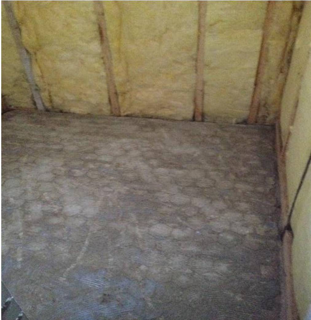
Kuva 9. Saunan seinä lastulevyjen purkamisen jälkeen.
