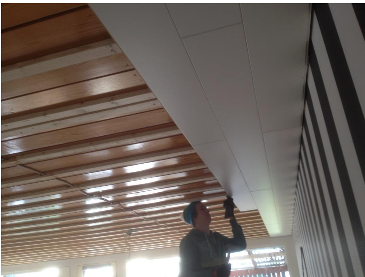
Kuva 40. Mdf- kattopaneelin asennus.
