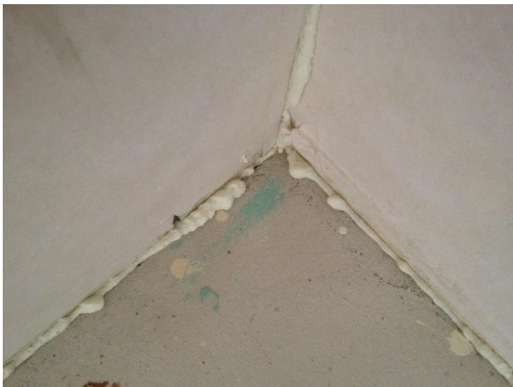
Kuva 36. Polyuretaanivaahdolla tiivistetty lattiaraja makuuhuoneessa.
