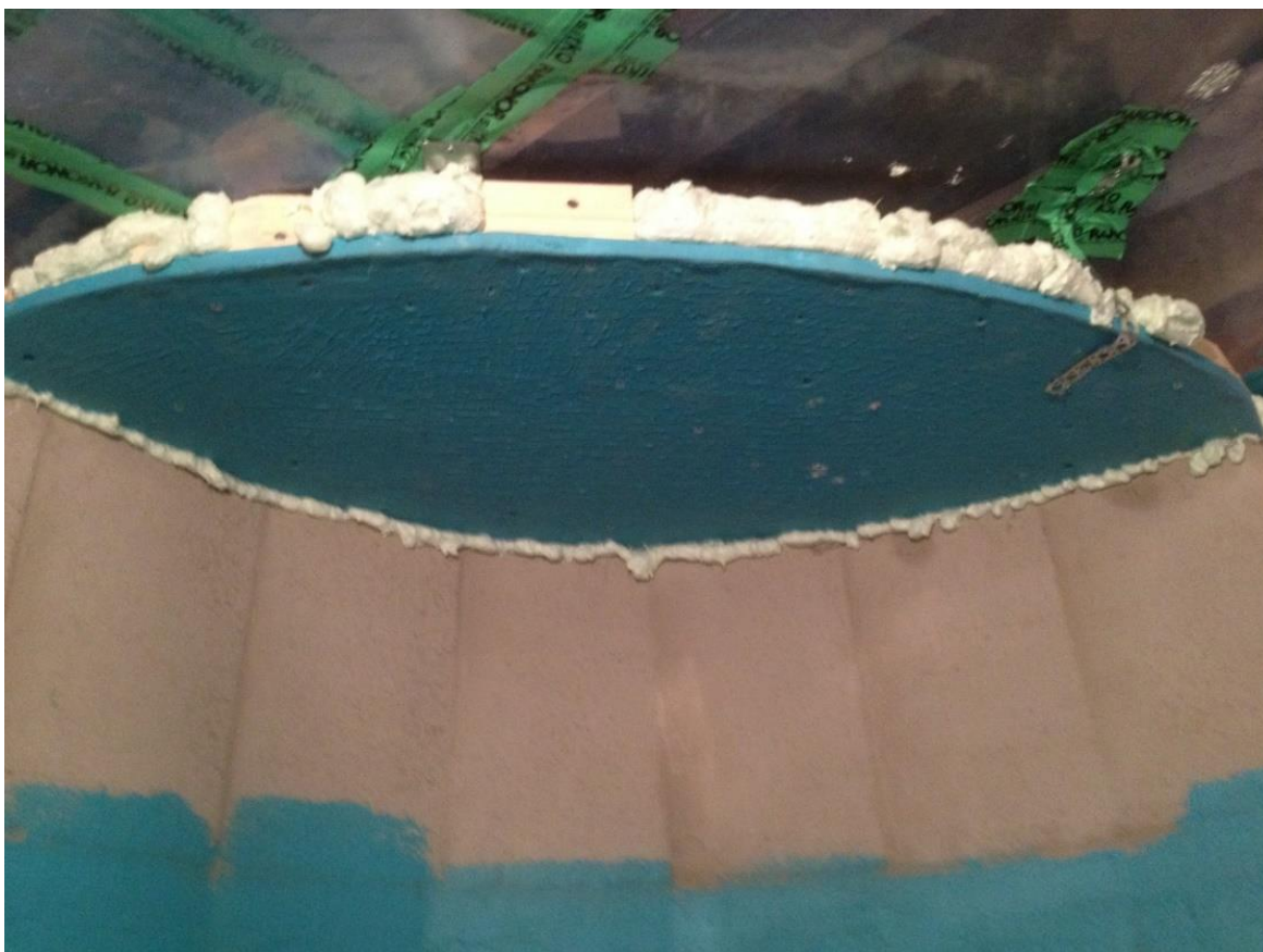
Kuva 21. Uuden suihkunurkkauksen katto.
