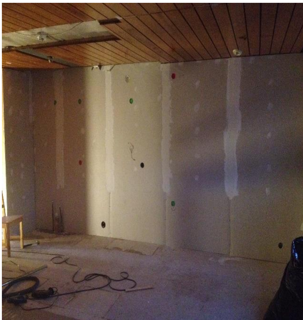
Kuva 10. Keittiön saumatasoitettu kipsilevyseinä.
