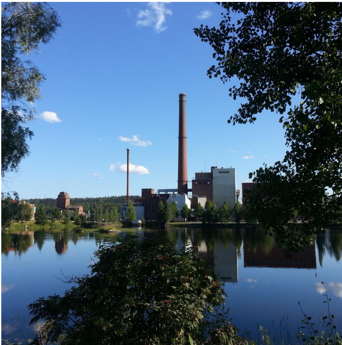
Kuva 2. Mäntän Energia Oy:n julkisivu.
