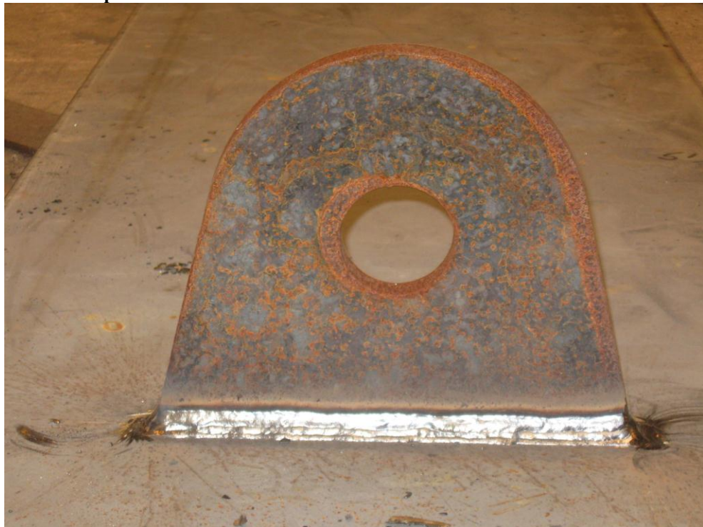
Kuva 15. Nostokorva asennettuna paikalleen.
