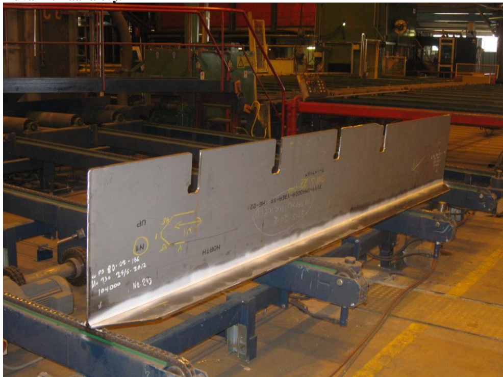
Kuva 13. T-palkki. Laipan ja uuman (neljä lovea bulpeille) saumaa ollaan tarkastamassa tunkeumanesteellä (valkoinen).
