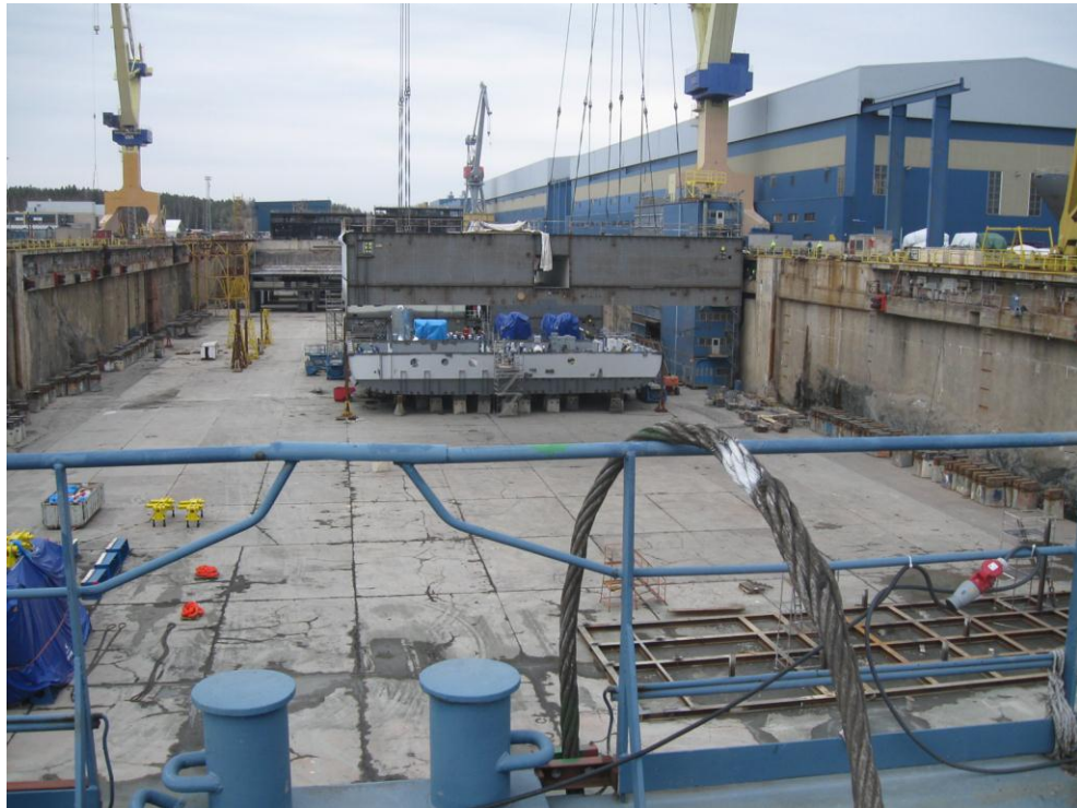
Kuva 22. Näkymä kokonaisuudessaan rakennusaltaasta.
